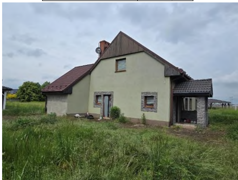
Zdj. nr 5: Nieciszów, działka nr 153/3 AM-1. Widok budynku mieszkalnego.
